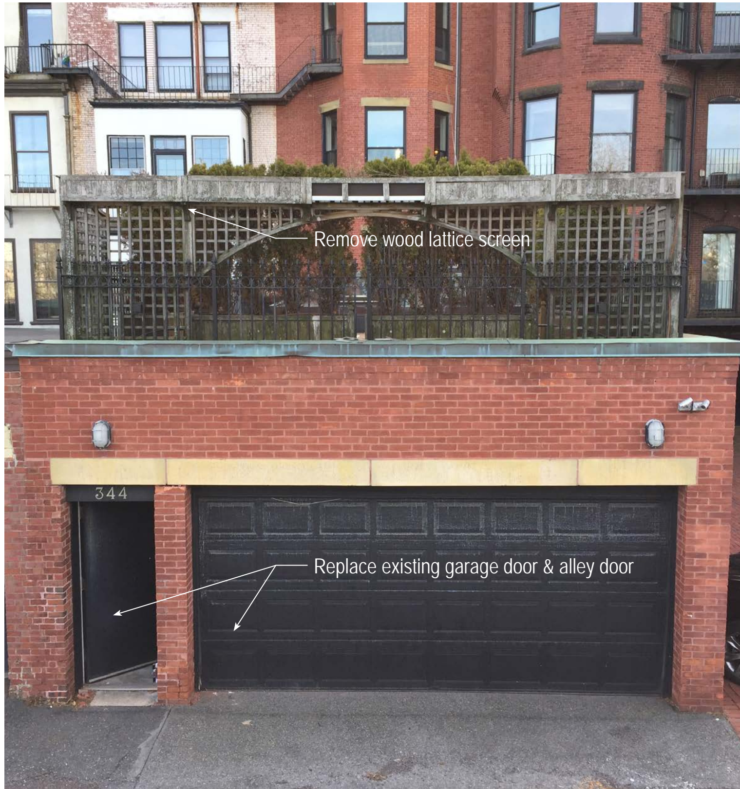
EXISTING GARAGE DOOR
