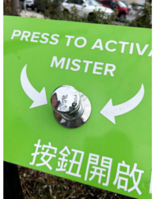
مثال على أحد صمامات التحكم المنظم. يمنع هذا النوع من الصمامات ترك المياه مفتوحة عن طريق الخطأ.
