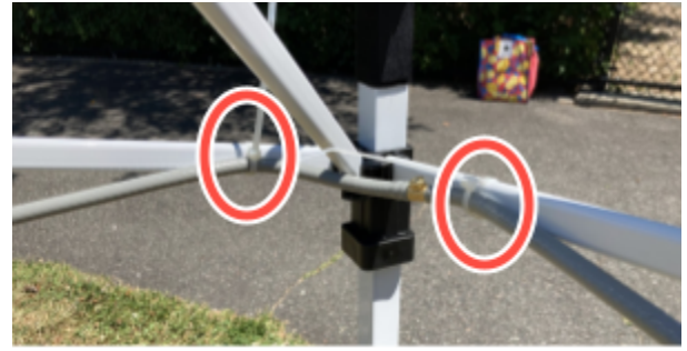
استخدام أشرطة الفيلكرو أو أحزمة الربط لربط خرطوم توزيع الرذاذ بإطار الخيمة.
