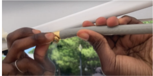
اجعل فوهات الرذاذ جميعها تشير نحو مركز الخيمة.
